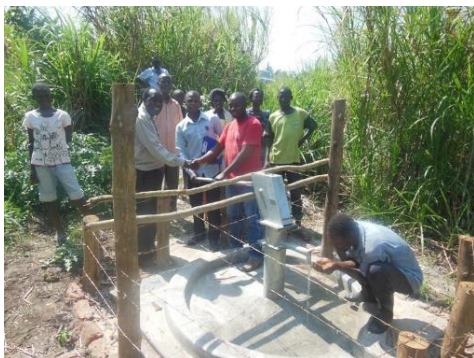
井戸が建設されたことで、住民は安全な飲み水を飲めるように。研修を受けた住民が管理している
