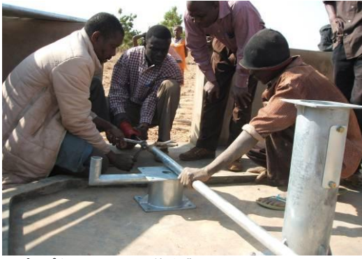
ポンプを取り付ける最終作業
