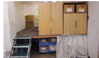
事務所の一部の床を上げ、その下を収納スペースに。上は面談スペース
