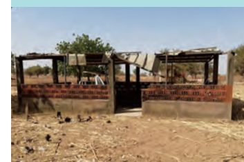
新活動地の母子保健センターは屋根がはがれている
